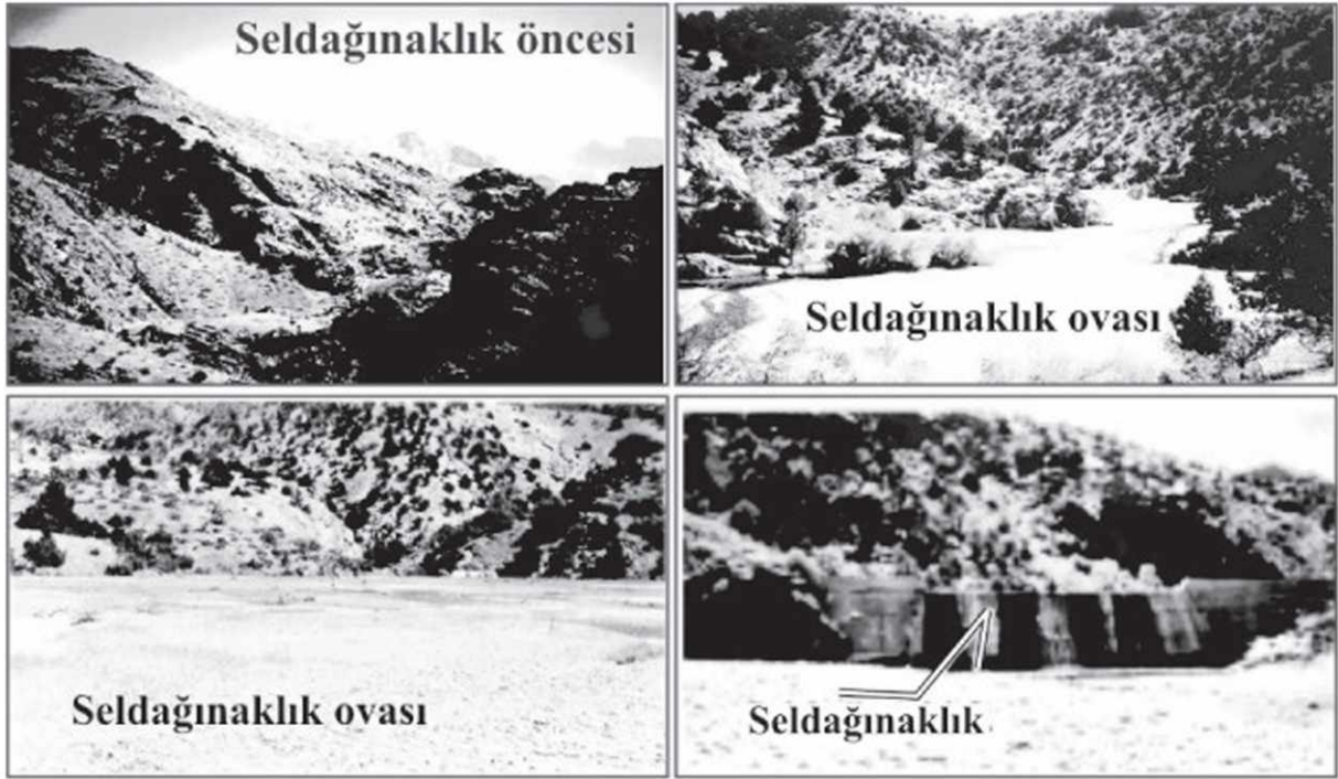
Şekil 2. Seldagimlilik yapısı öncesi ve sonrası saha durumu (Kırkgeçit vadisi, Pozantı). Figure 2. The valley before and after the construction of an artificial dyke (Kırkgeçit valley, Pozantı).
